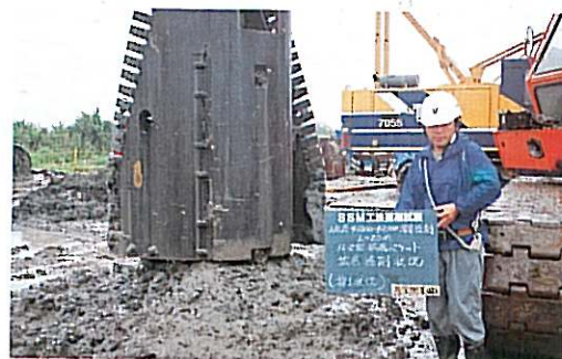
▲拡底掘削状況
