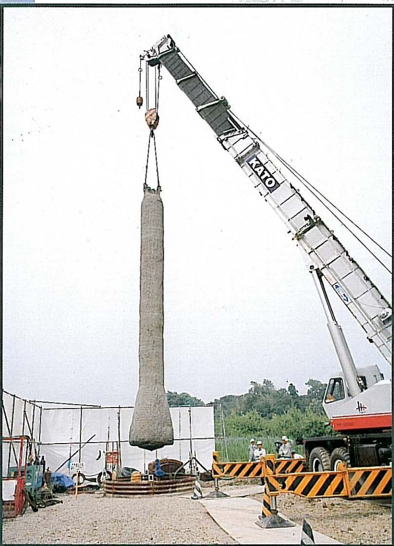
● 財日本建築センター立会 掘出し杭 杭長10.2m 軸部径φ1000 拡底部径φ1700
