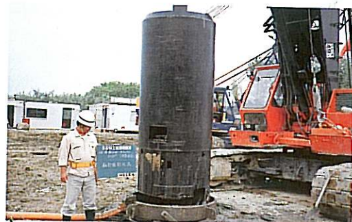
▲軸部掘削状況
