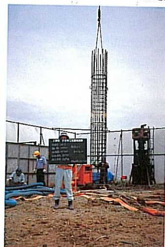
▲鉄筋建込み
